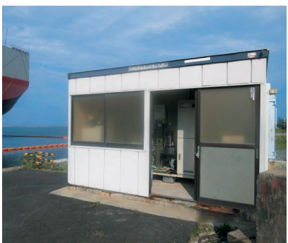
排水監視モニターによる排水規制(津)
