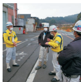
TBM(朝礼)点検(舞鶴)
