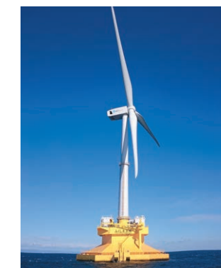
アドバンストスパー型大型洋上風力発電浮体
