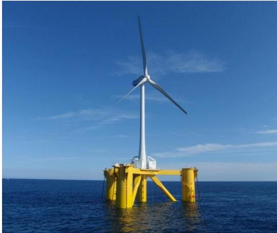
2MW ダウンウィンド型浮体式洋上発電設備
