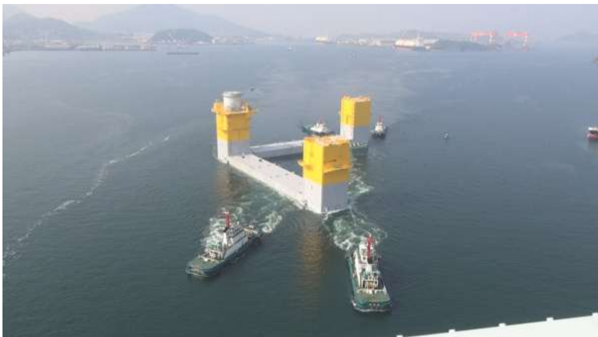
長崎港内を曳航される 7MW 油圧ドライブ型浮体式洋上風力発電設備用浮体
