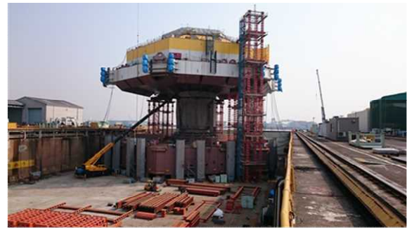
図 5 ドックでの浮体部建造
