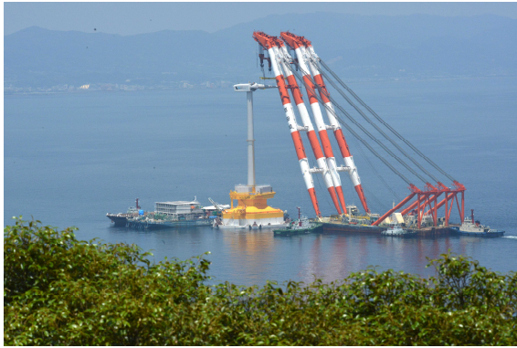
図7 ブレード取付
