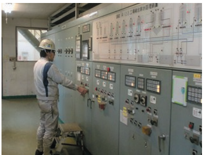
総合排水処理場の緊急事態訓練(呉)
