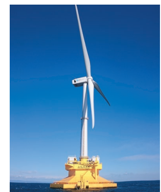
アドバンスパー型大型洋上風力発電浮体
